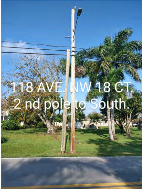
118 AVE NW 18 CT 04/07/2022
